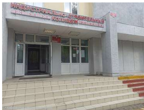
Рис.1 – учреждение образования «Бобруйский государственный индустриально-строительный колледж»
